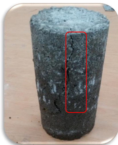
شکل ۴. نحوه گسترش ترک در نمونه‌های مقاومت فشاری
