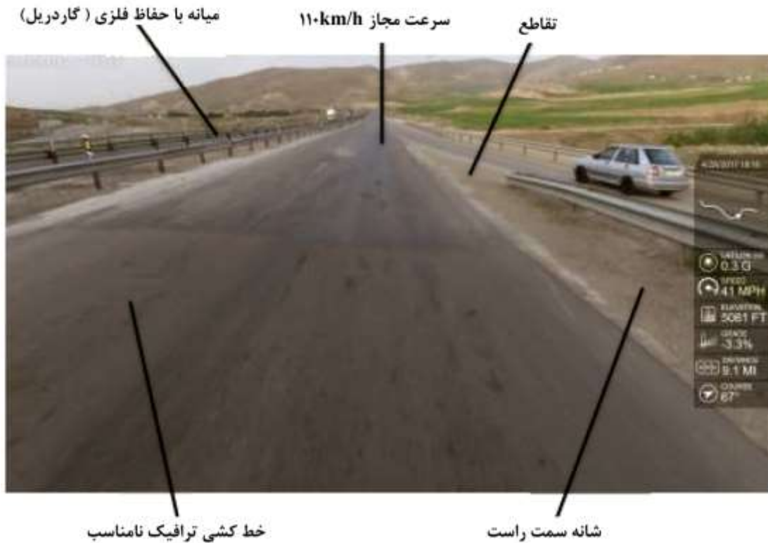
شکل ۵. عکس منتخب کنارگذر شرقی کرمانشاه
