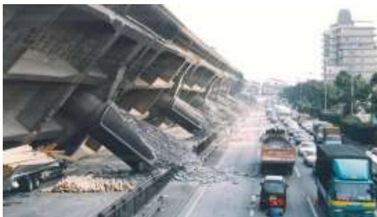
شکل ۱. تخریب پل در زلزله‌های کوبه (۱۹۸۵) و نورتریج (۱۹۹۴) (قاسمی و همکاران، ۱۹۹۶)
