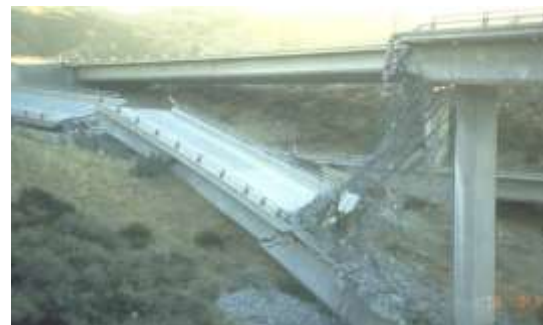
شکل ۱. تخریب پل در زلزله‌های کوبه (۱۹۸۵) و نورتریج (۱۹۹۴) (قاسمی و همکاران، ۱۹۹۶)
