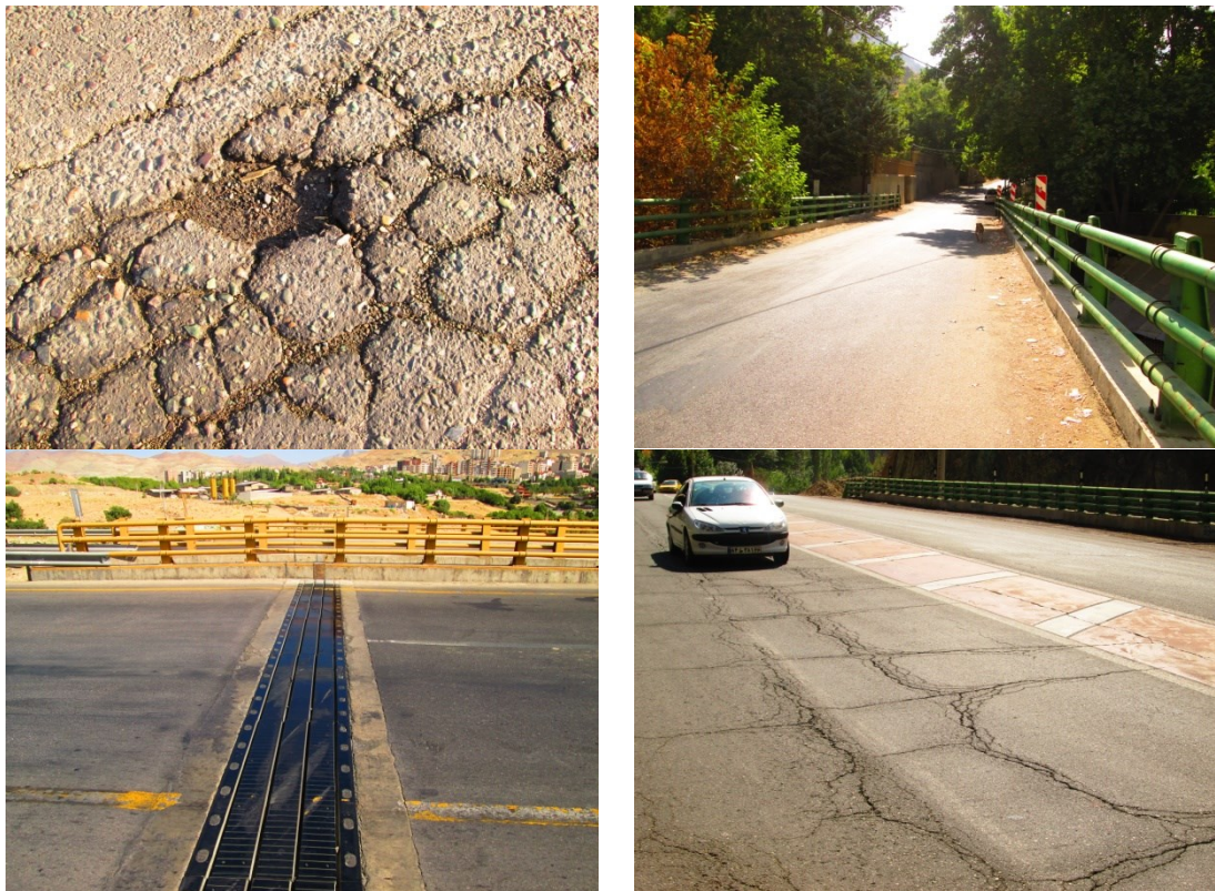
شکل ۷. بررسی وضعیت درزهای انبساط در پل‌ها
