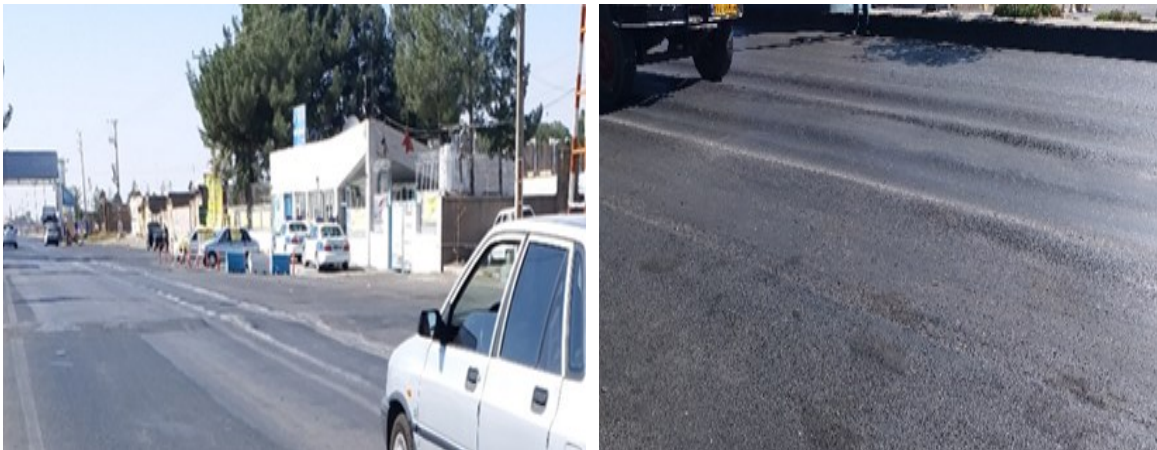
شکل ۸. کیفیت پایین روسازی در محل پلیس‌راه سبزوار با وجود سن کم روکش آسفالت
