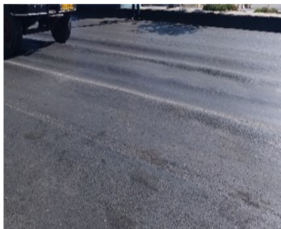
شکل ۸. کیفیت پایین روسازی در محل پلیس راه سبزوار با وجود سن کم روکش آسفالت
