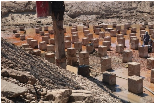
شکل ۸. شمع‌های اجرا شده در بستر رودخانه و موقعیت گودبرداری محل قفل کشتیرانی سد مارد
