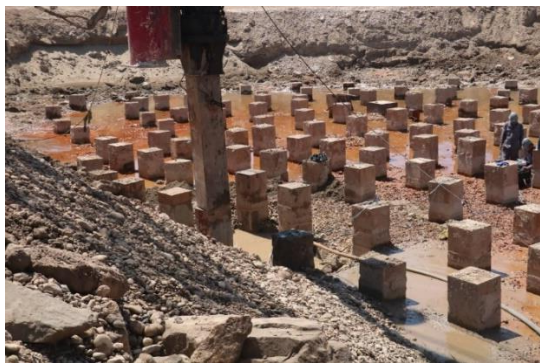
شکل ۸. شمع‌های اجرا شده در بستر رودخانه و موقعیت
