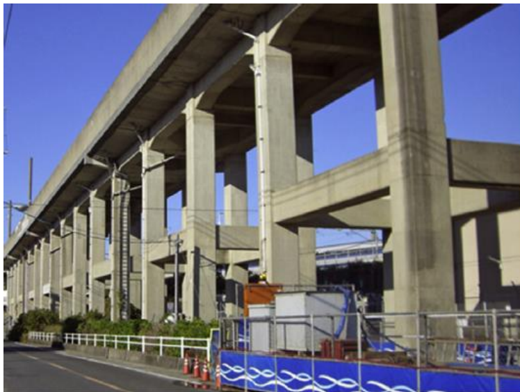
شکل ۱. نمونه‌ای از پل راه‌آهن با قاب صلب
