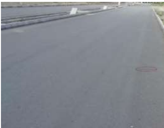
شکل ۱: روسازی آسفالتی بدون خرابی در شرایط خشک
