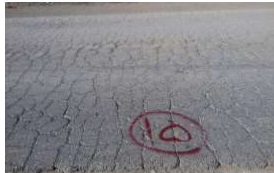
شکل ۲. روسازی با خرابی پوست سوسماری
