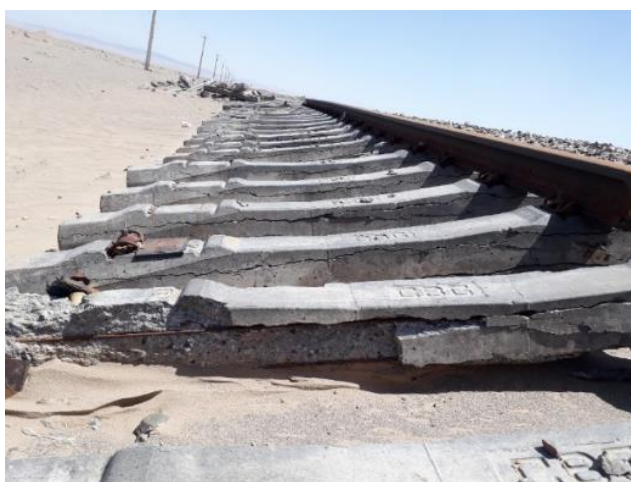
شکل ۴. تراورس‌های بتنی ترک خورده در یکی از کوپلاژهای تعویض شده
